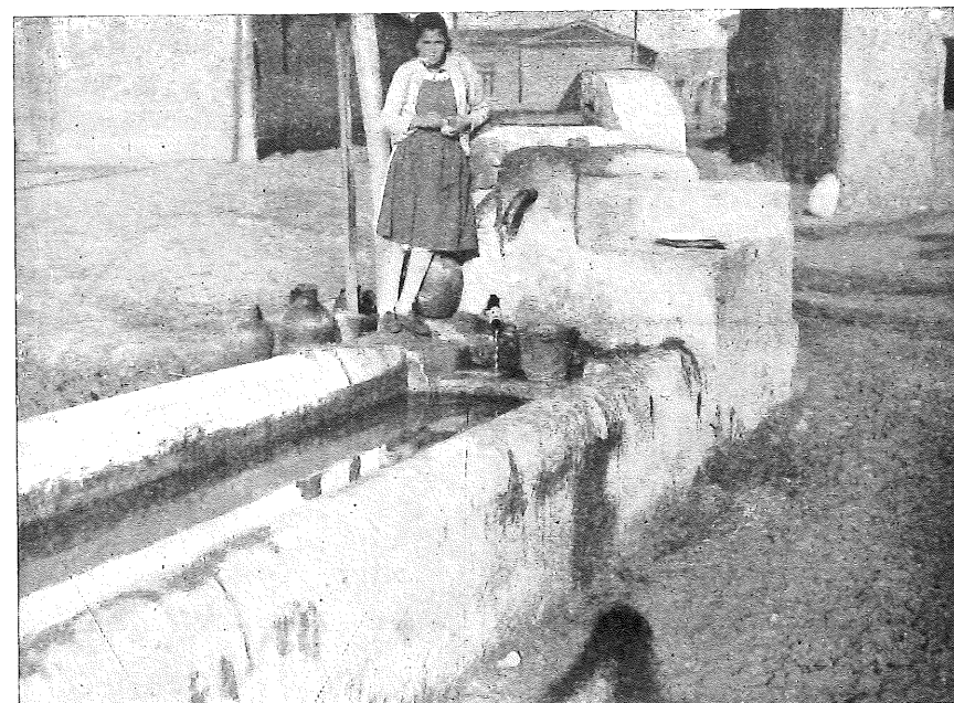
Pozo artesiano en Coreses.
